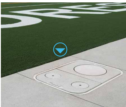
APLICACIONES EN EL HORMIGÓN DEL PERÍMETRO
